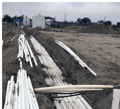
Instalación de Tubería de Remediación
