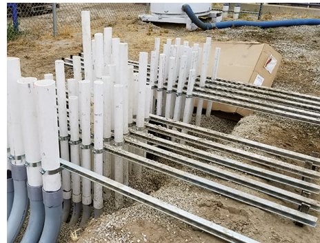
Instalación de Pozos de Remediación
